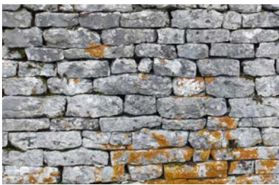
Gartenmauer im französischen Jura: Schichtenmauerwerk.
