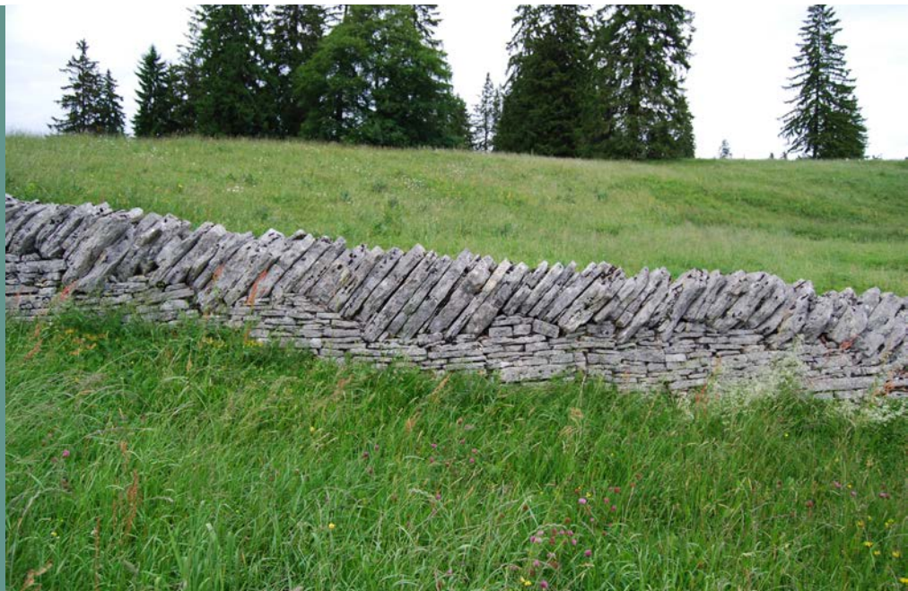
Weidemauer bei Champroz im Berner Jura. Die unterschiedlich hohen Decksteine wurden einzeln eingepasst und untermauert.
