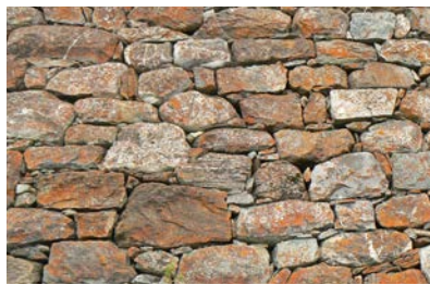
Stützmauer in Graubünden: Bruch- und Lesesteinmauerwerk bis Bruchstein-Schichtenmauerwerk.
